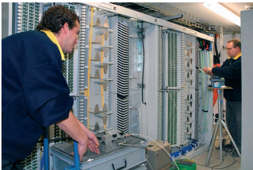
Einblasen der Glasfaser im Technikraum
