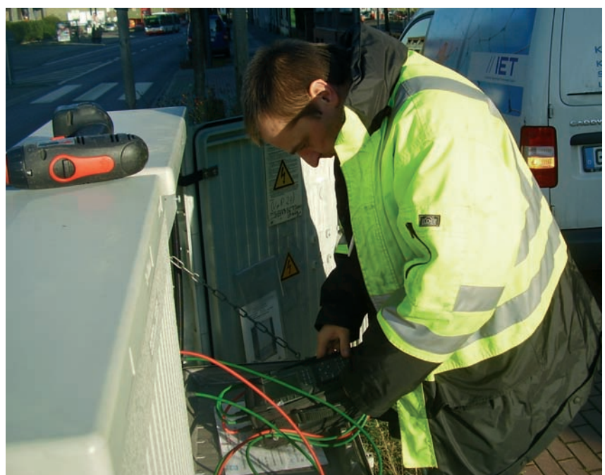
IET-Messtechniker beim Einmessen mit dem Stealth Feldmessgerät SDA 5000
